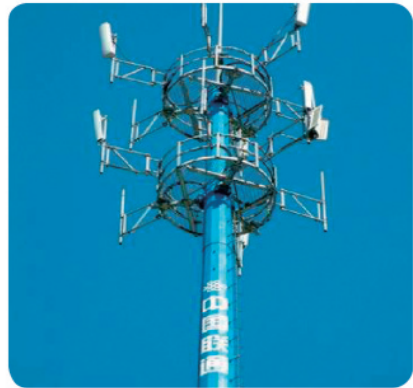
通讯塔 Communication pole
