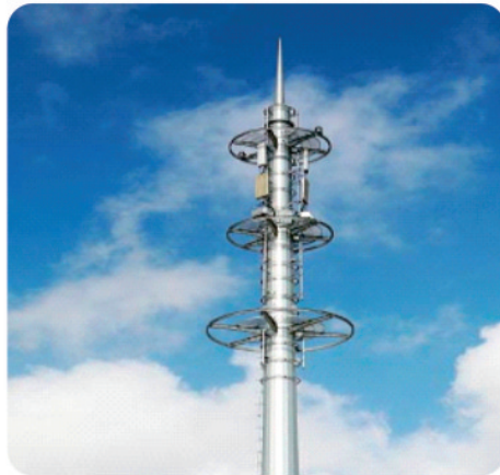
通讯塔 Communication pole
