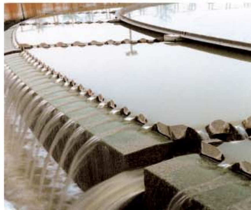
污水处理 Sewage treatment plant
