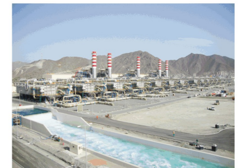
海水淡化 Desalination
