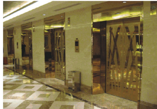
电梯门 Lift door
